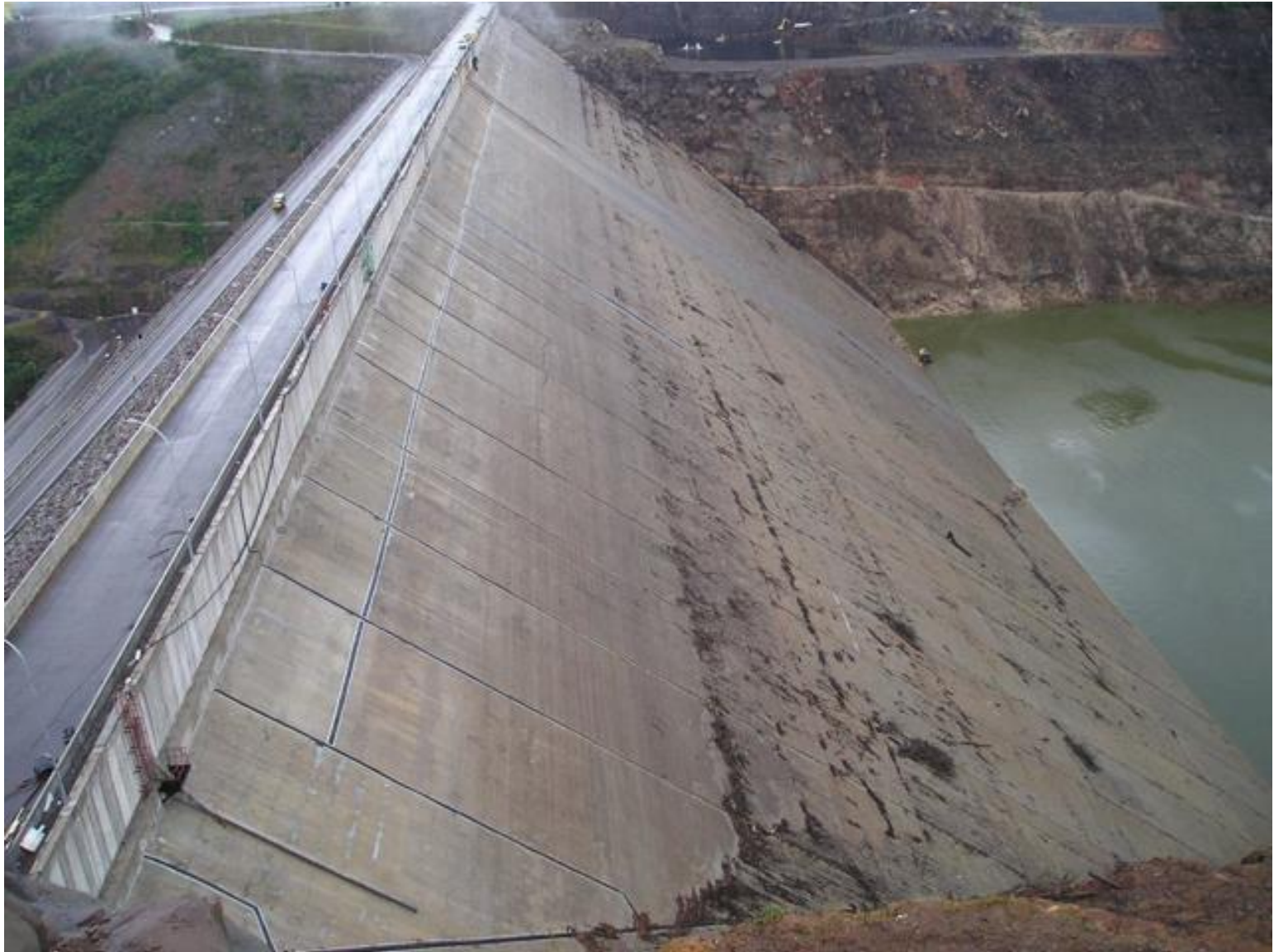
Presa Campos Novos , Brasil – Altura: 202 m
