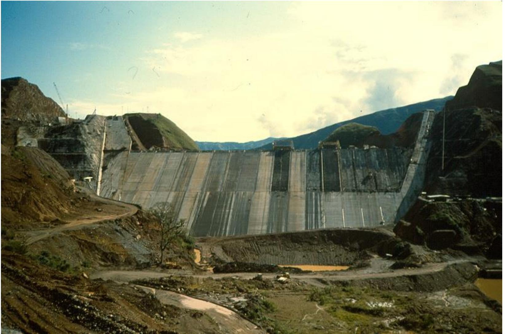
Presajina Salvajina, Colombia - CFRD, Altura: 148 m
