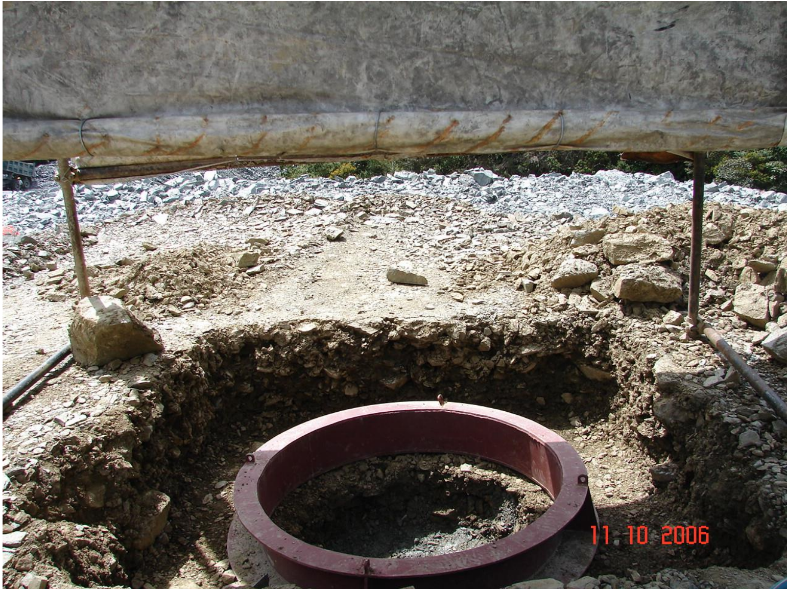
Presa Mazar – Terraplén de Prueba
