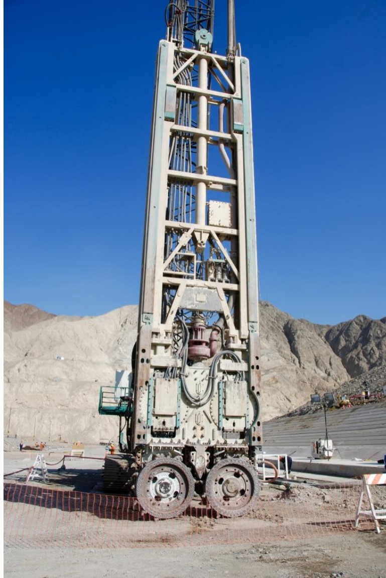
Presa Chavimochic, Perú – CFRD – Altura: 100 m – En Construcción
