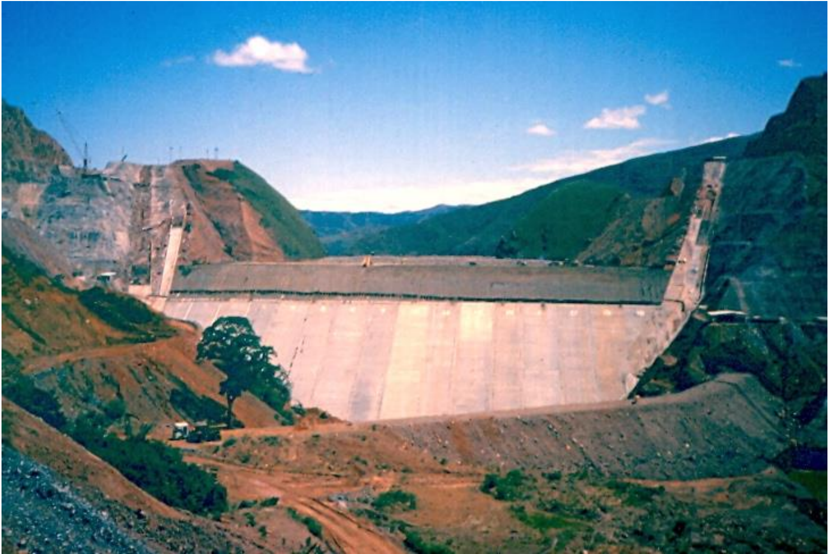
Presajina Salvajina, Colombia - CFRD, Altura: 148 m
