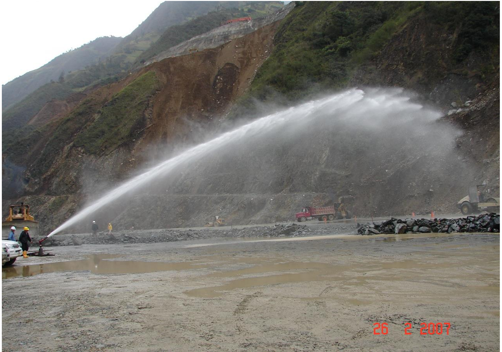
Presa Mazar – Colocación de Enrocados
