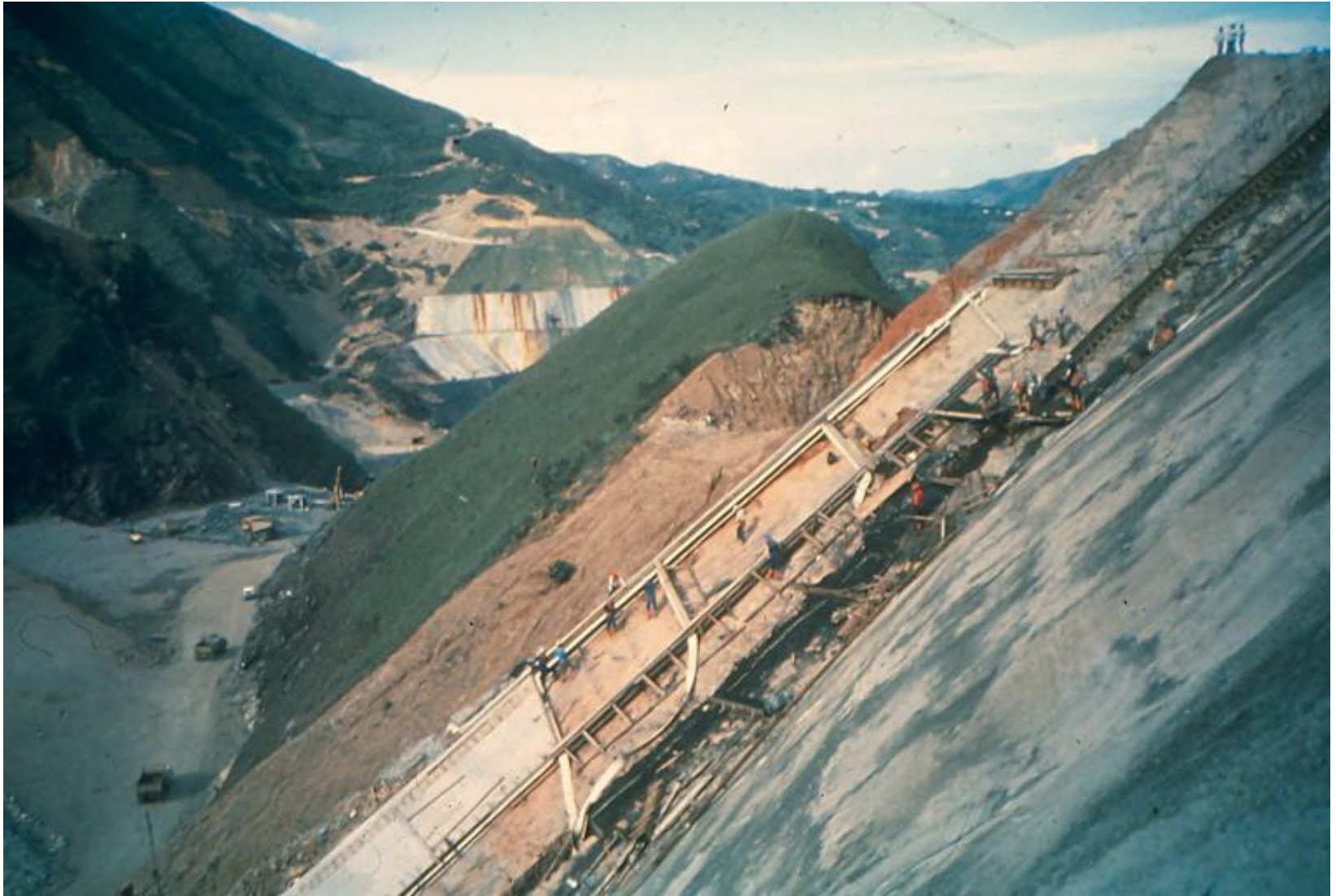
Presa Salvajina – Fundación del Plinto: Suelo Residual
