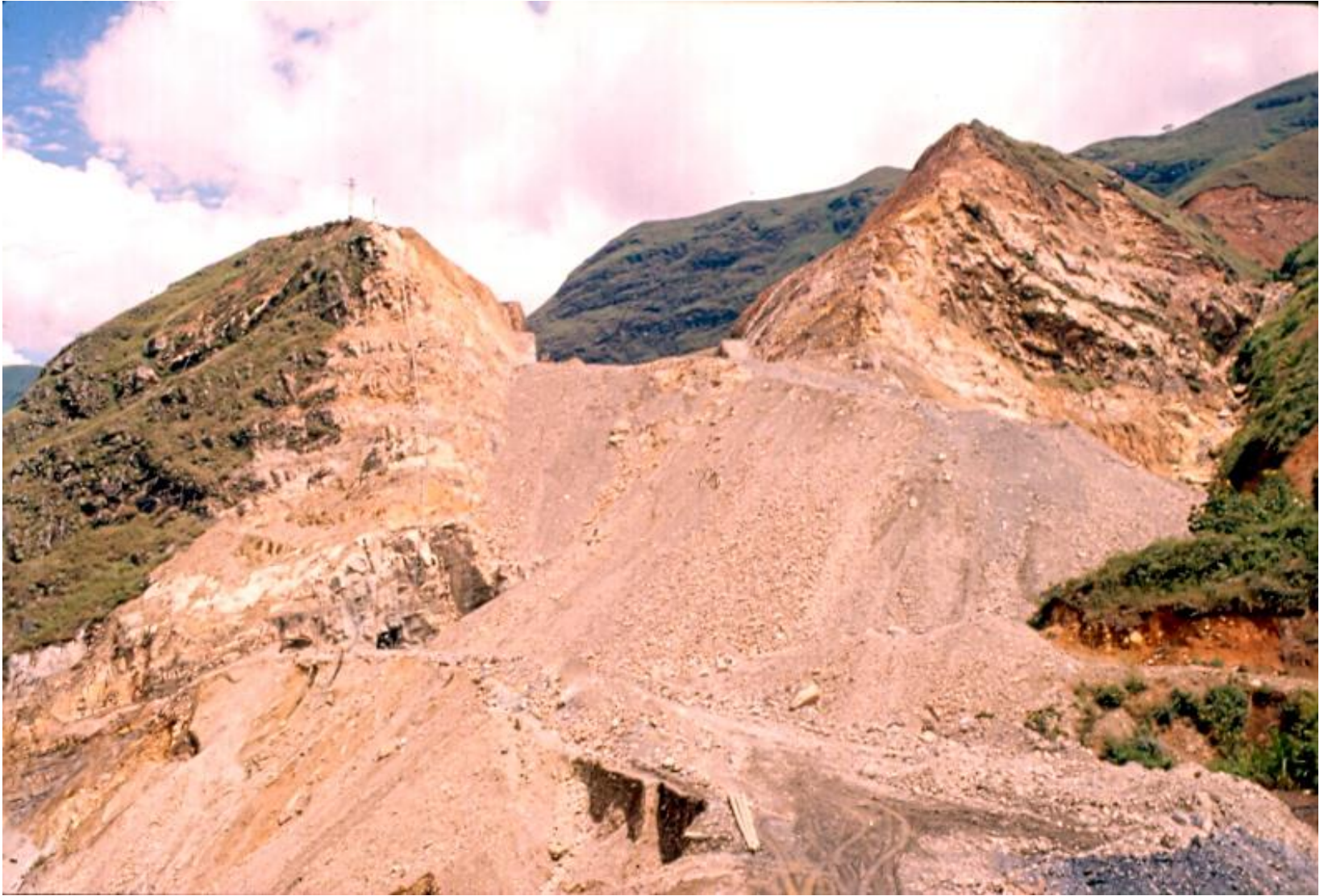
Presa Salvajina – Excavación del Aliviadero: Enrocado – Zona 4
