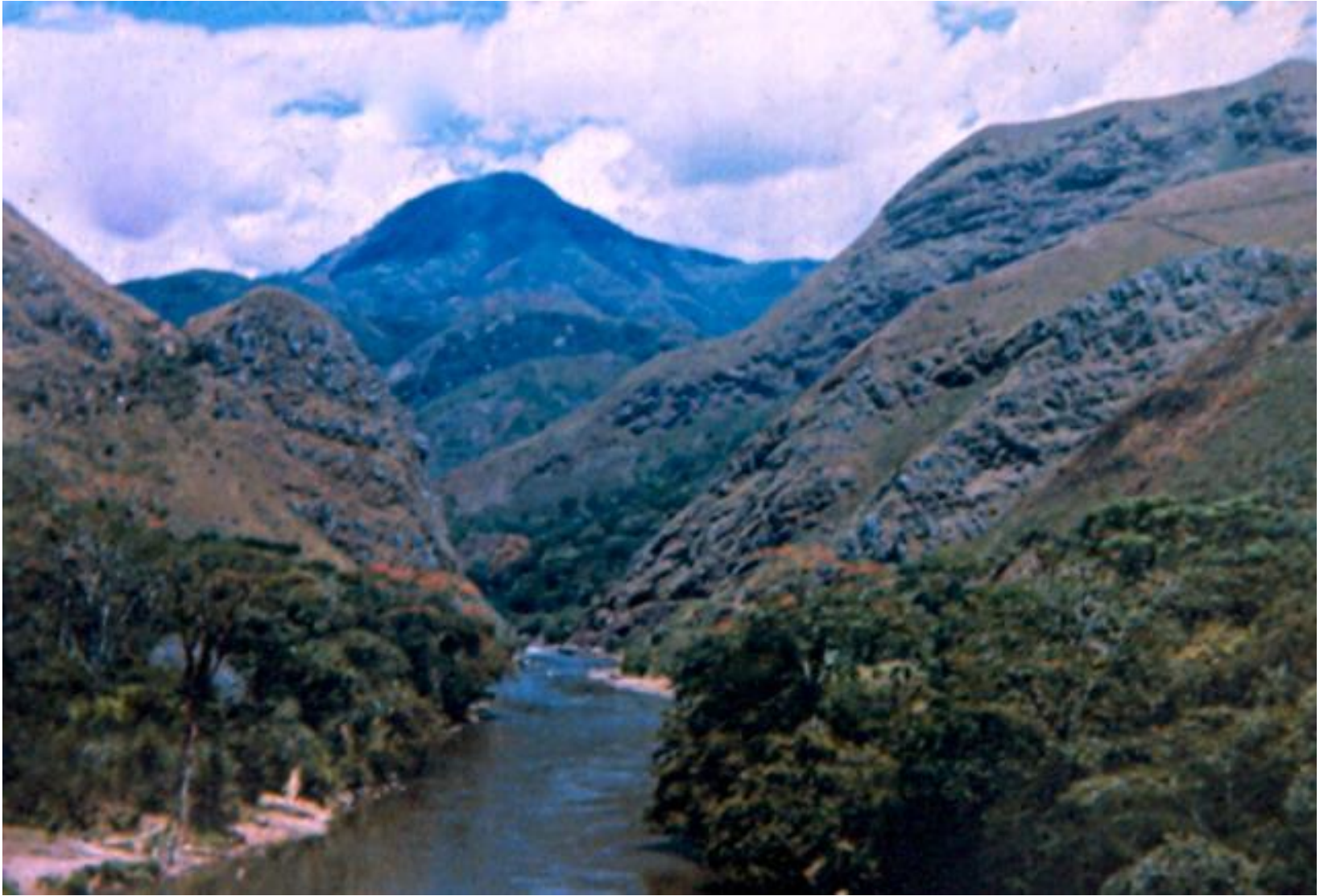
Presa Salvajina, Colombia - CFRD, Altura: 148 m
