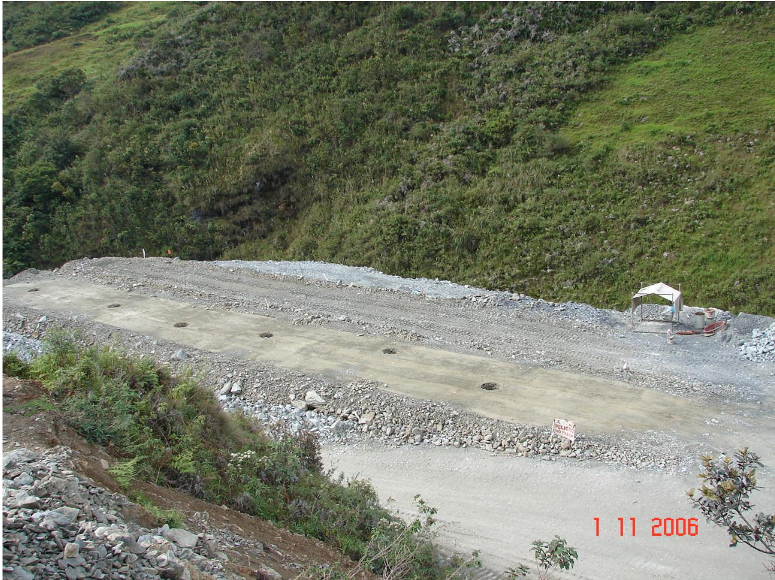
Presa Mazar – Terraplén de Prueba
