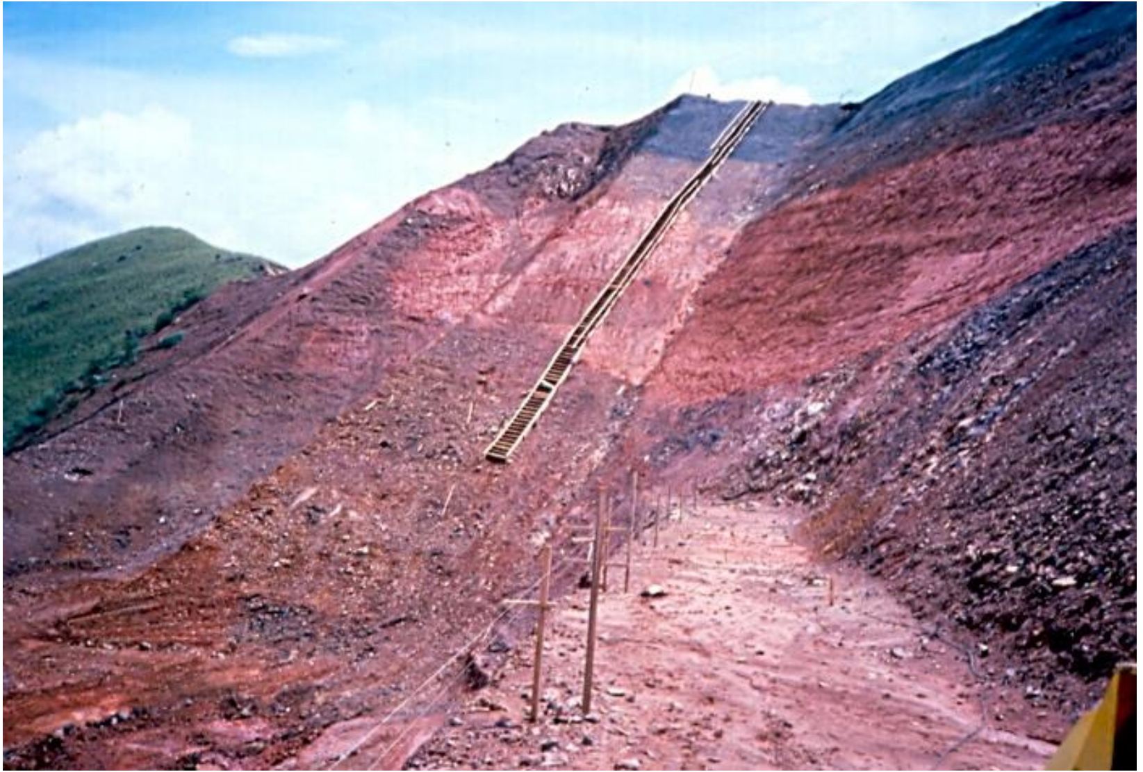
Presa Salvajina – Fundación del Plinto : Suelo Residual
