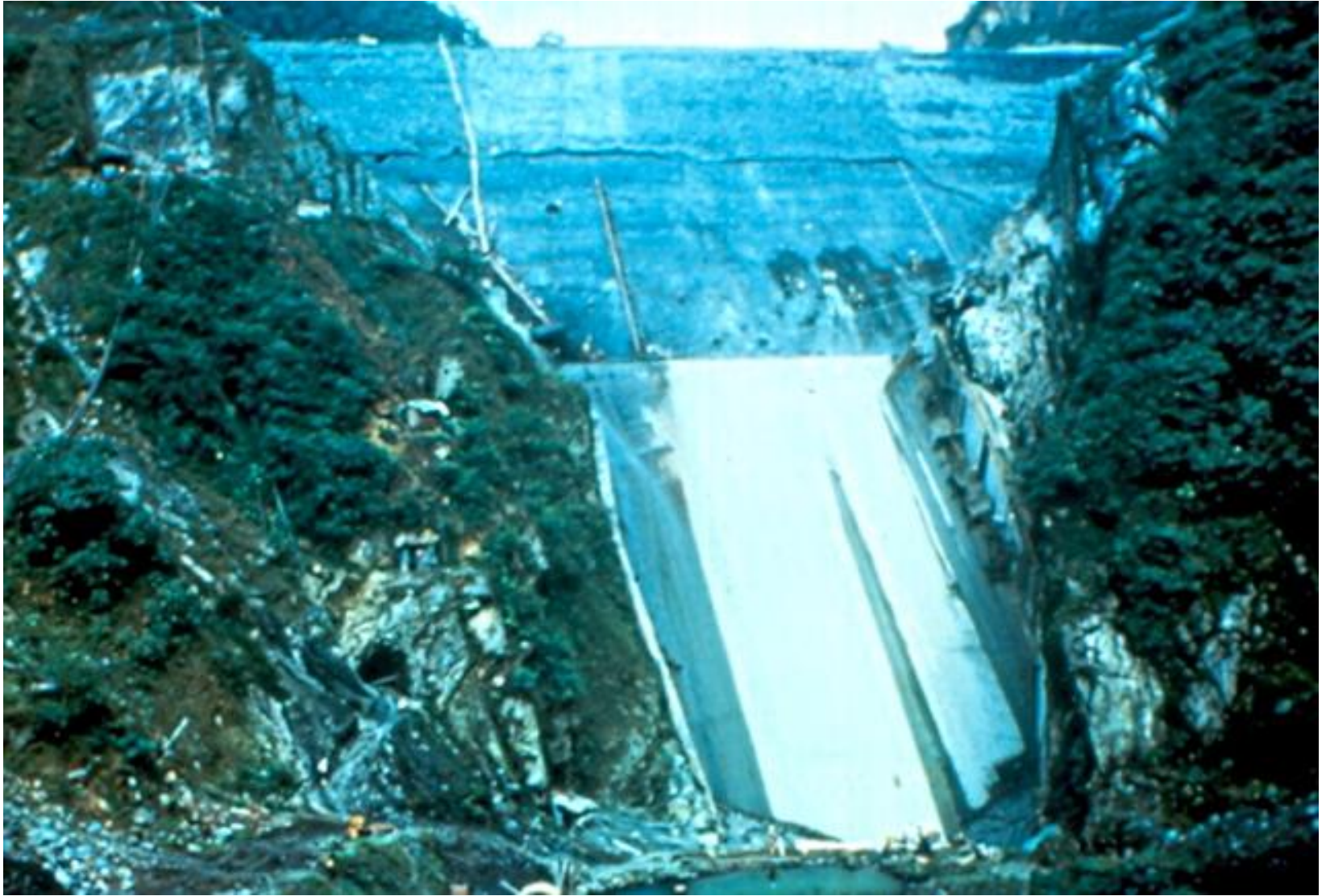
Presa Alto Anchicayá, Colombia - CFRD, Altura: 140 m - 1975
