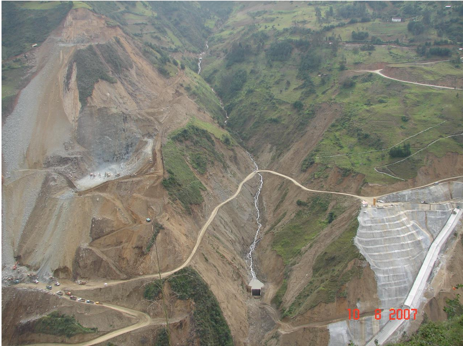
Presas Mazar – Explotación de Cantera de Enrocados
