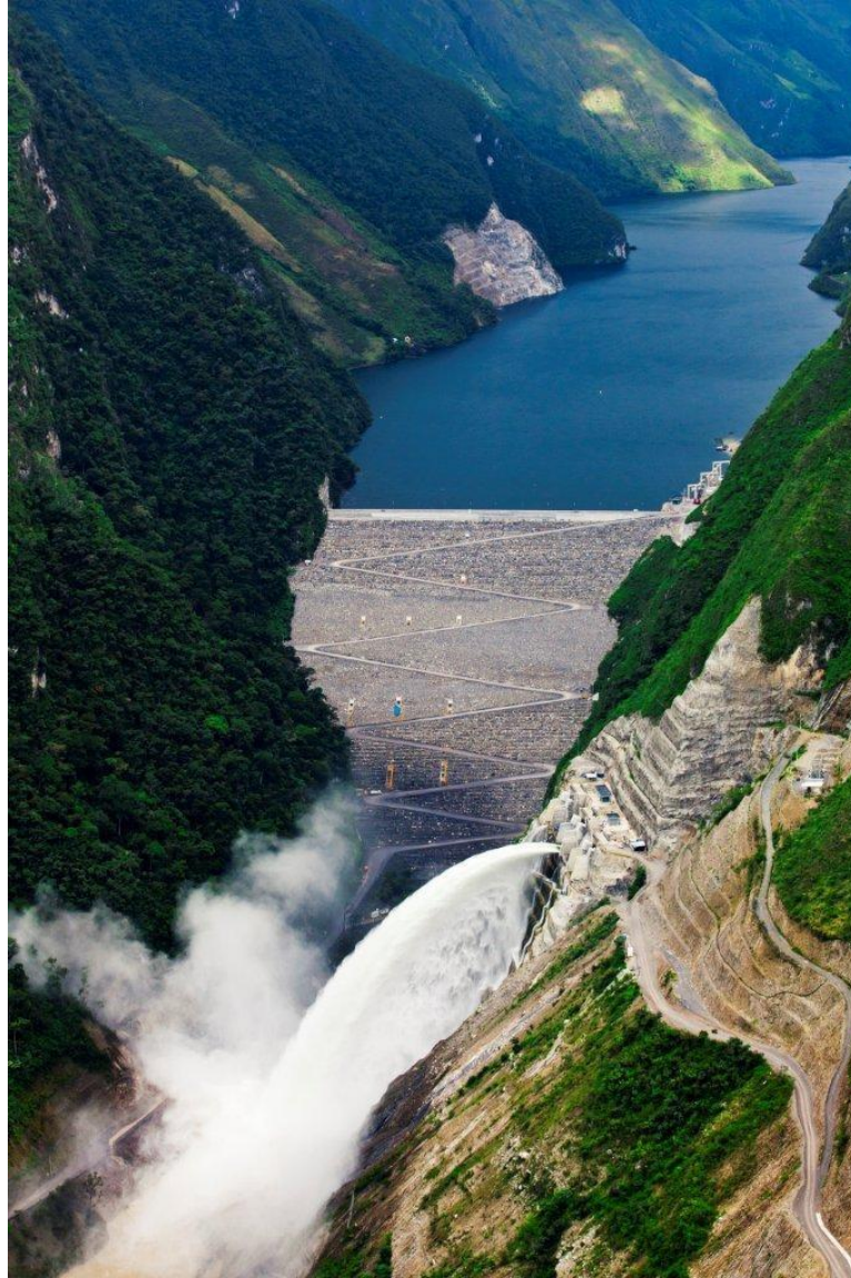
Presas Chaglla, Perú - CFRD, Altura: 200 m
