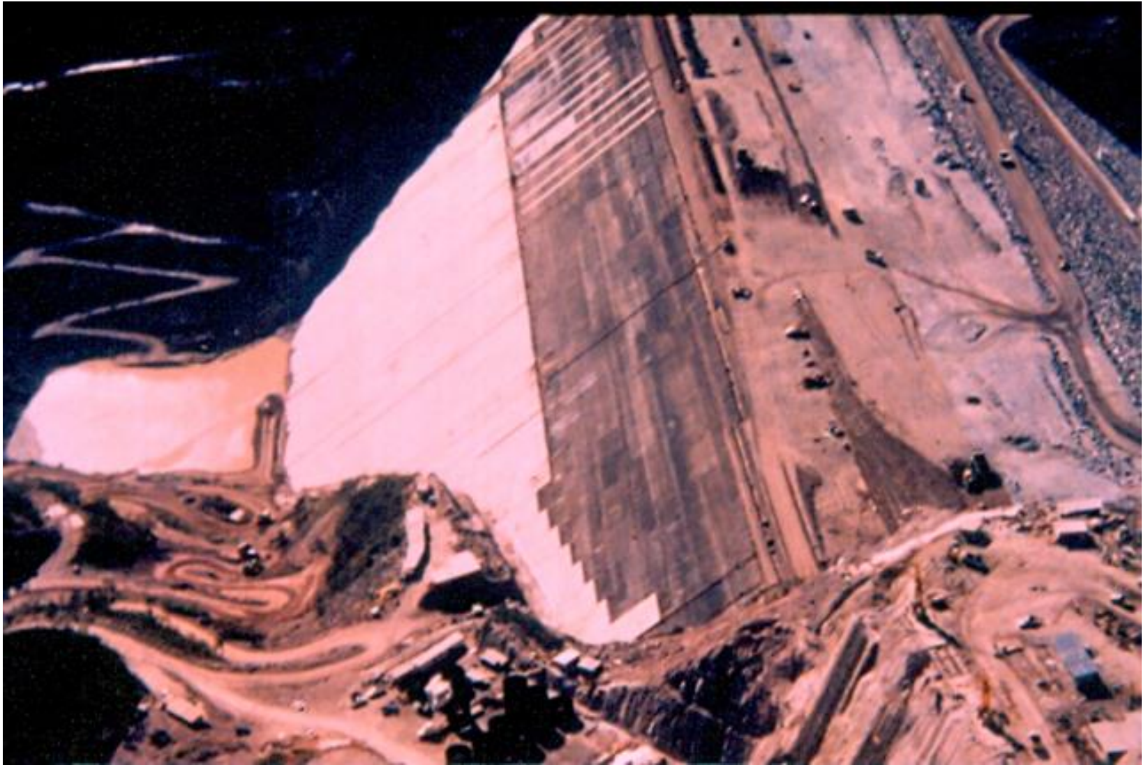
Presa Aguamilpa , México – Altura: 187 m - 1987
