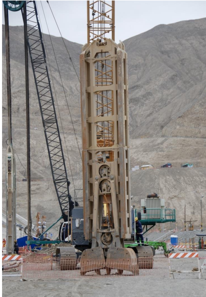
Presa Chavimochic, Perú – CFRD – Altura: 100 m – En Construcción
