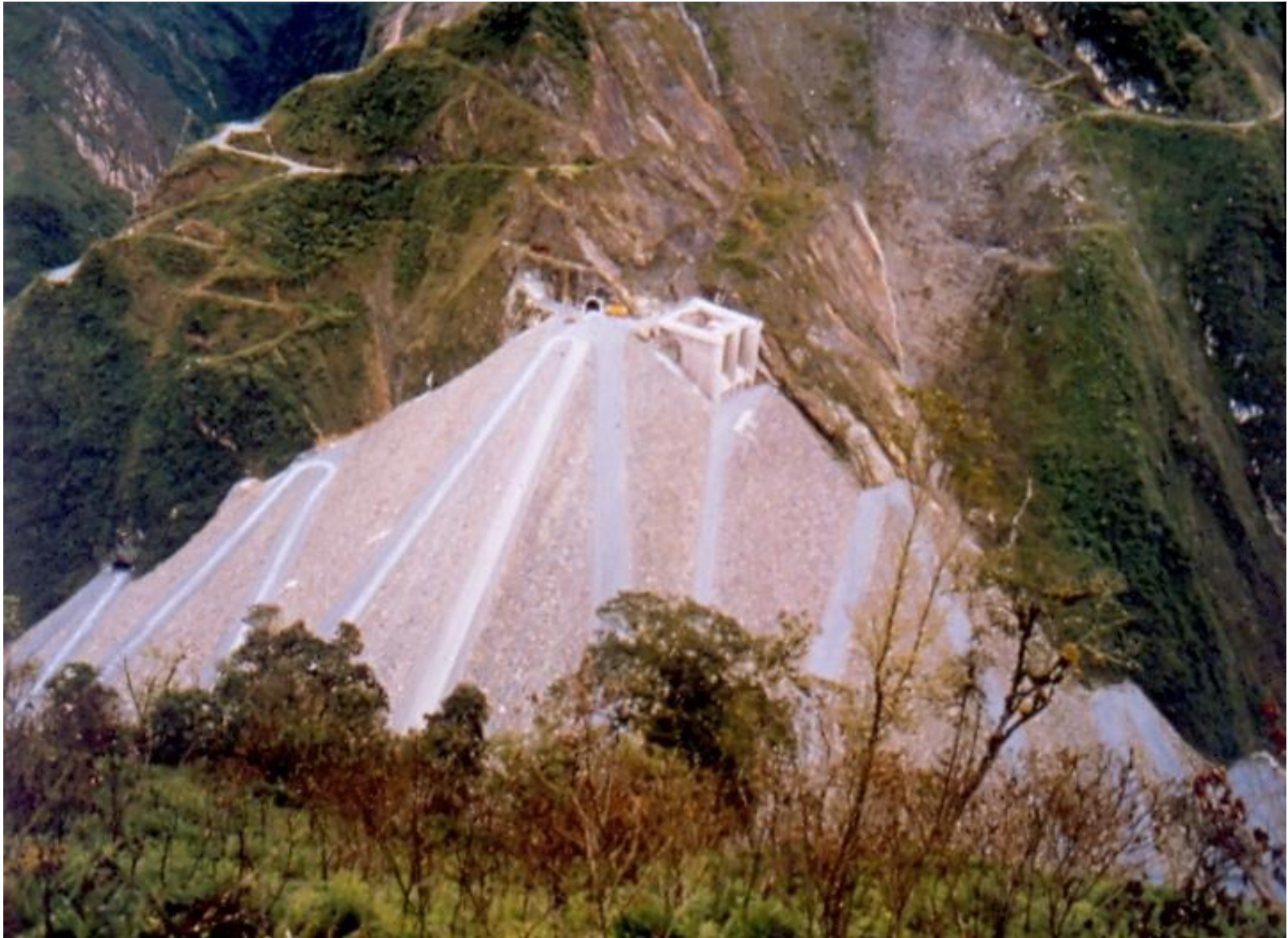
Presa Guavio, Colombia - ECRD, Altura: 243 m - 1989
