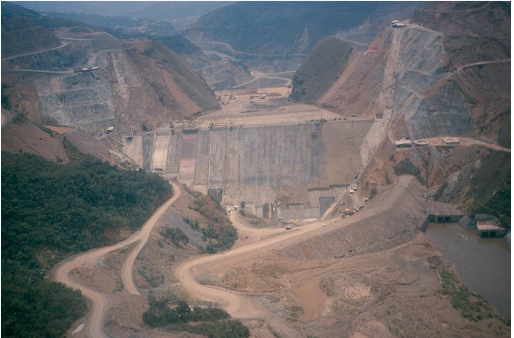
Presajina, Colombia - CFRD, Altura: 148 m
