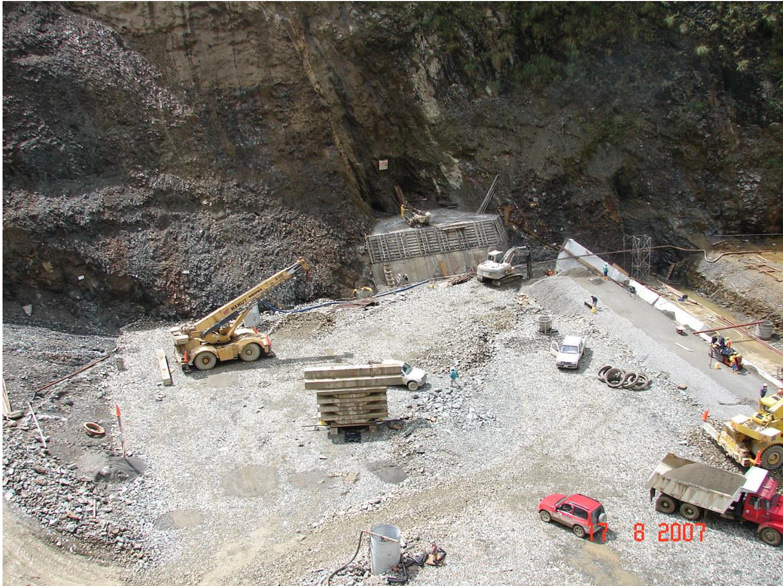
Presa Mazar – Ensayo de Placa
