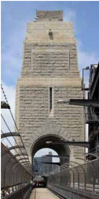
La torre sudeste recubierta de placas de granito provenientes de Moruya.
