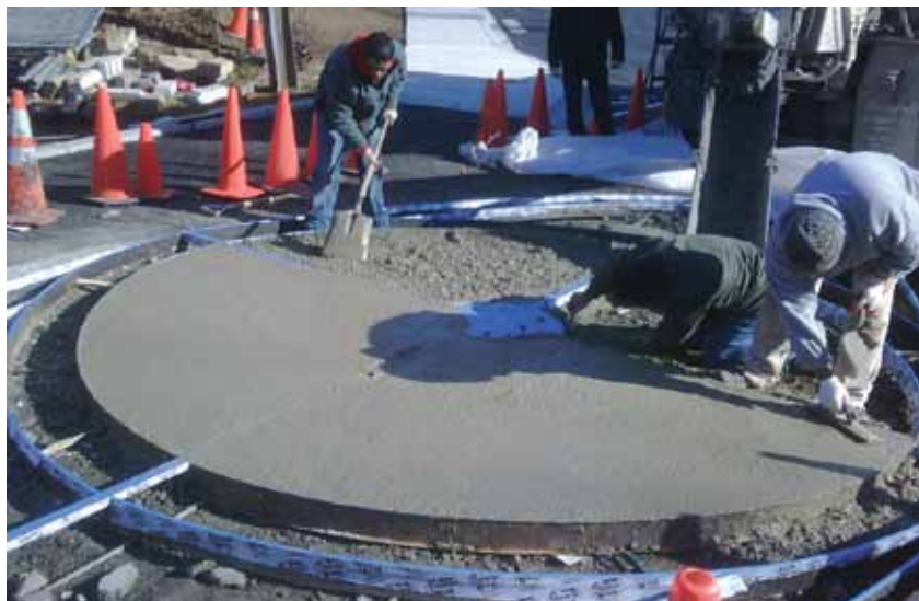
- NUEVA MEZCLA. Así se consigue un hormigón menos contaminante.
