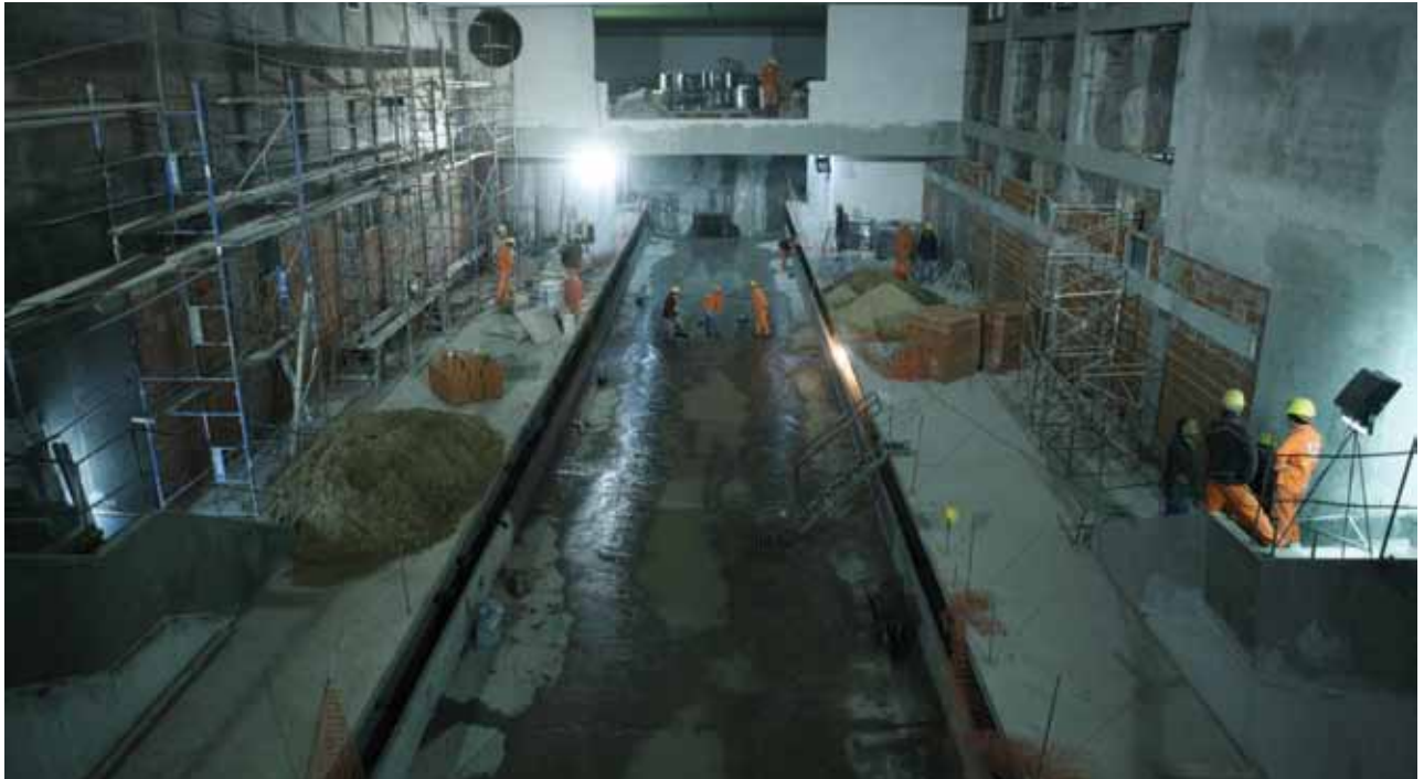
– ESTACIONES. Se está construyendo el tramo norte de la H: Córdoba, Santa Fe, Las Heras; y se seguirá con Facultad de Derecho.
