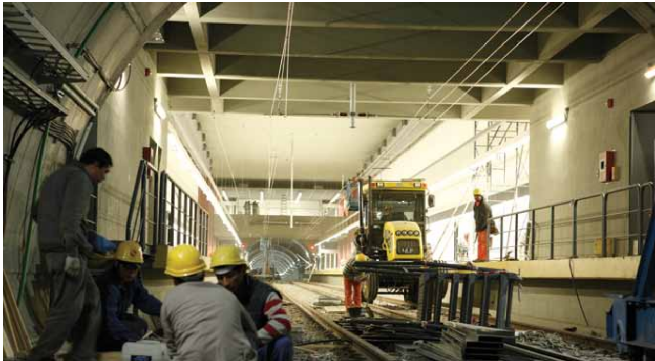
– CRECIMIENTO. Las obras de ampliación actual de la red es la más grande de los últimos 60 años.
