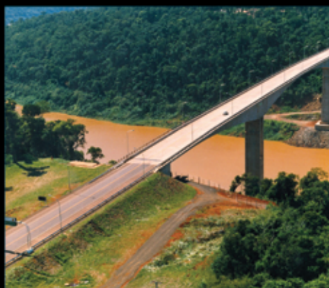
PUENTE INTERNACIONAL TANCREDO NEVES
