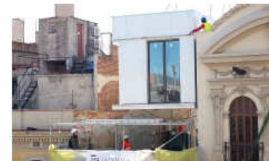
Posicionament del primer mòdul
