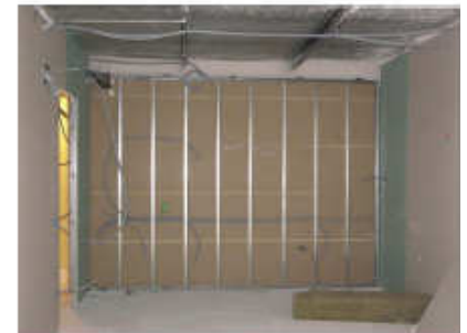
Muntatge de partició i envans de plaques de centre guix sobre estructura de perfil d'acer
