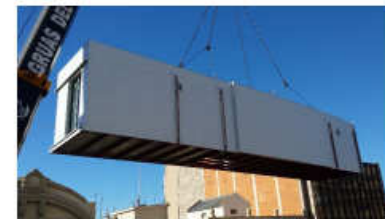
Aixecament dels mòduls
