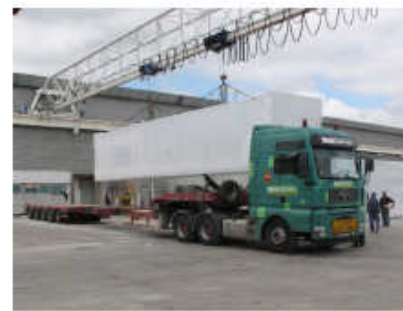
Mòdul carregat i desplaçat pel pont grua
