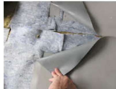
Unió de quatre mòduls sense acabar (l'al·liment està tallat i la membrana sense soldar)
