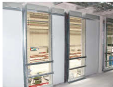
Plafons sandwich de fegana des de l'interior, abans de rebre un segon al·liment i les plaques de centre guix
