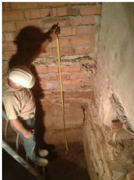
Cales realitzades per a l'estudi estructural de la finca
