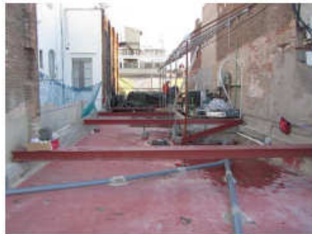
Acondicionament de coberta per a rebre els mòduls
