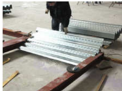
Col·locació de capa d'acer galvanitzat plejada com a encofrat perdut en els forjats col·laborants de formigó armat
