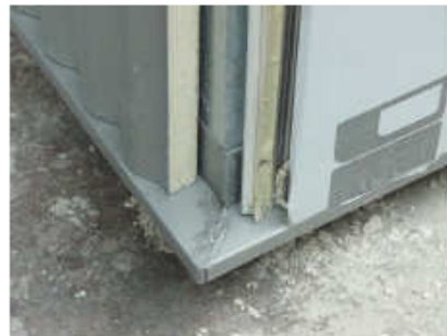
Detall mostrant els plafons de fegana muntats sobre
