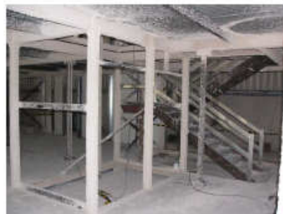
Vista de les estructures de la caixa d'ascensors i de l'escalera amb protecció al
