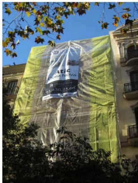
Instal·lació de bastida per rehabilitar façana
