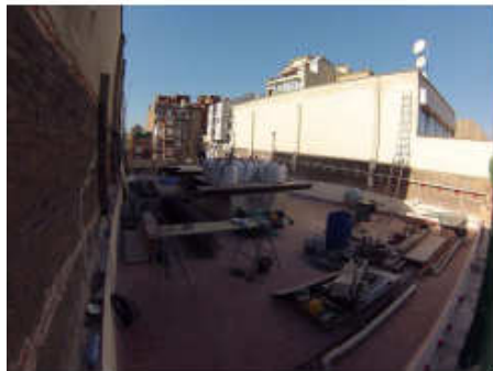
Endemec de la coberta existent per el posterior acondicionament
