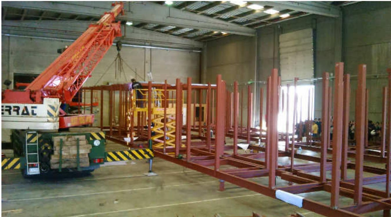
Inicio del montaje de la estructura metálica previamente mecanizada.
