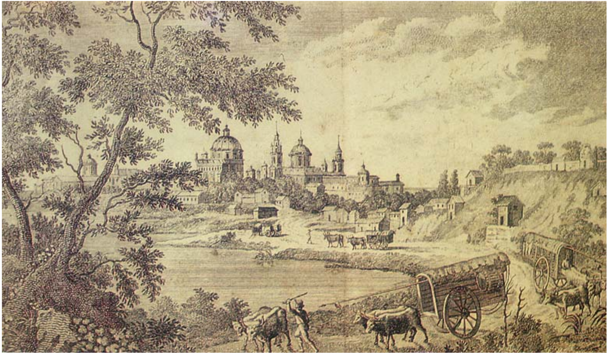
BUENOS AIRES – “EL CAMINO DE LA RIBERA” Actual Avenida Leandro N. Alem
