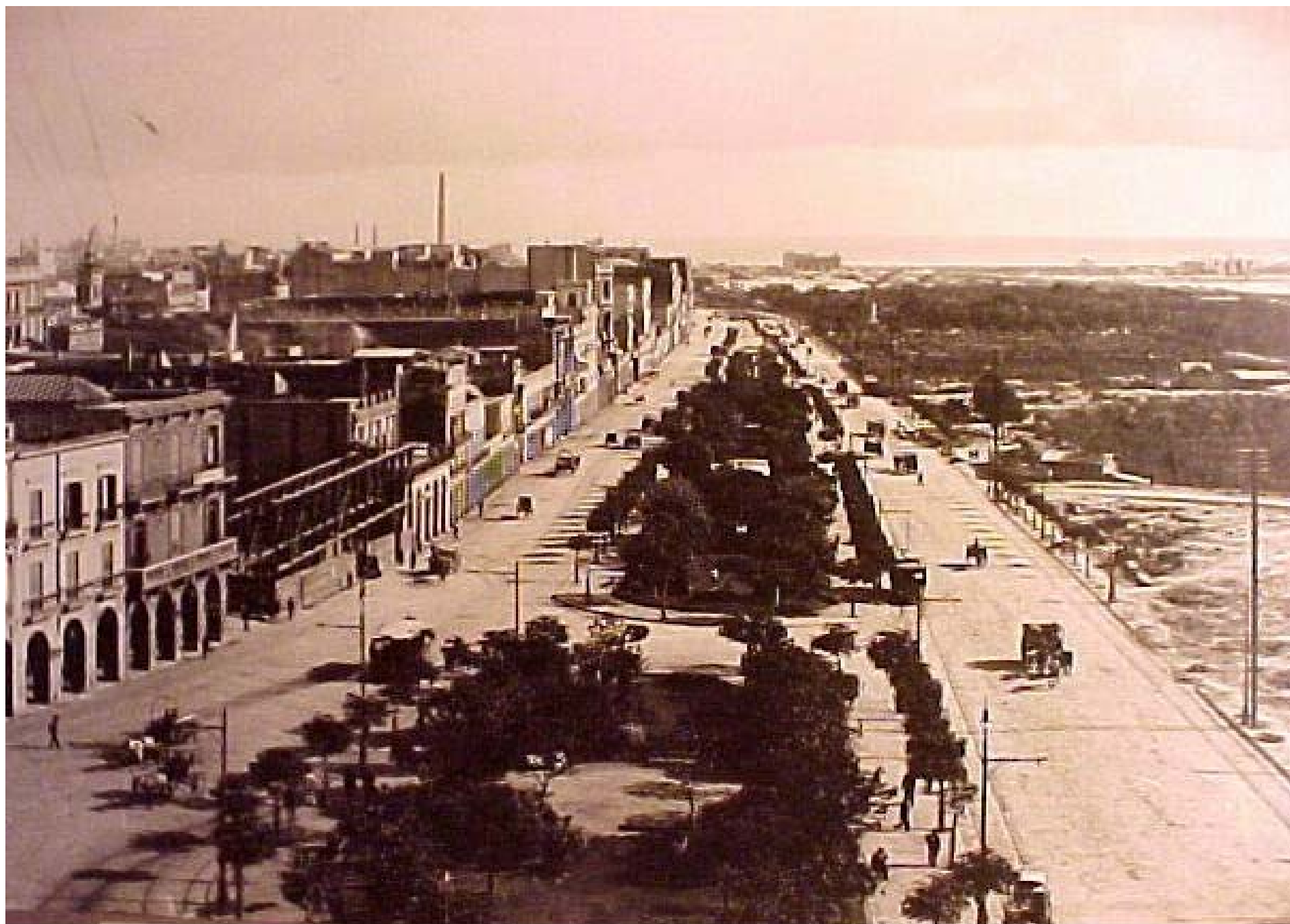
Paseo de Julio y obras de Puerto Madero. Hoy Paseo Colón. A la izquierda la recova. A.G.N.
