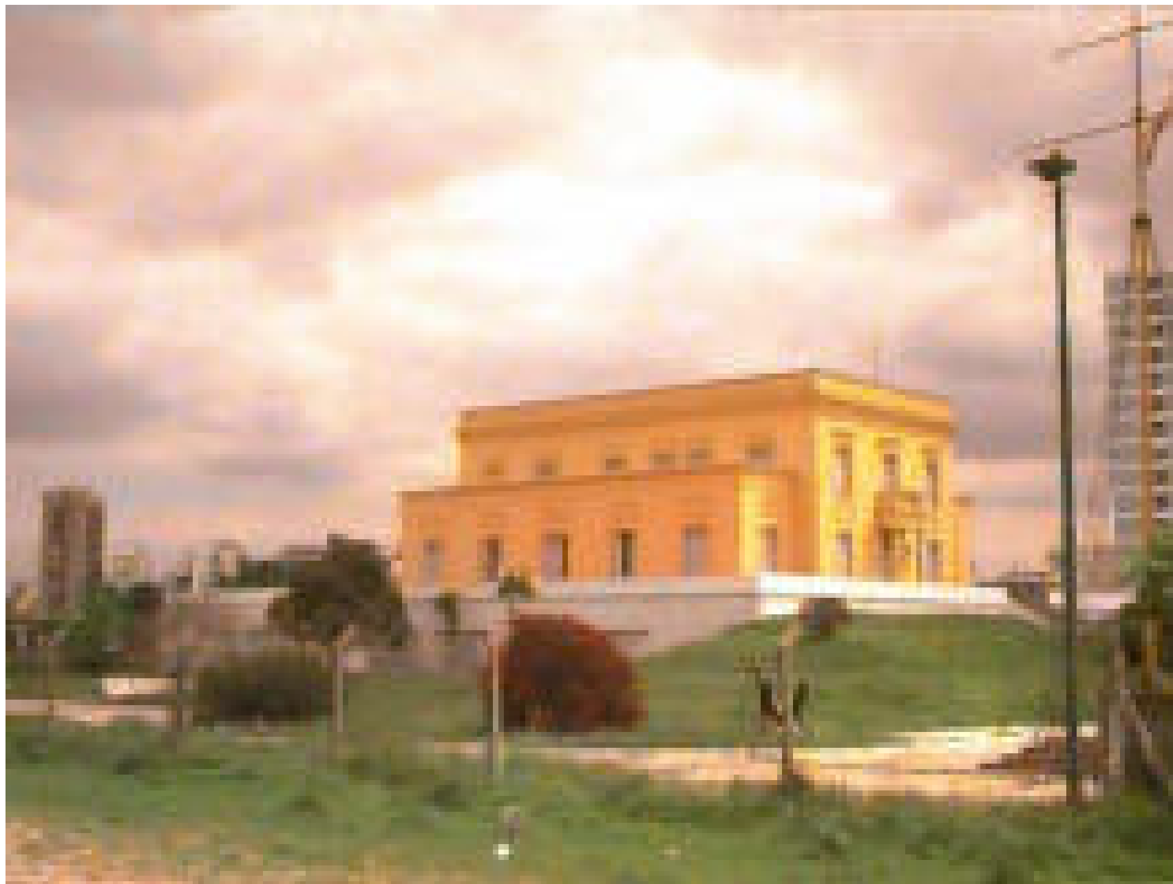
“CASA AMARILLA” Contrafrente
