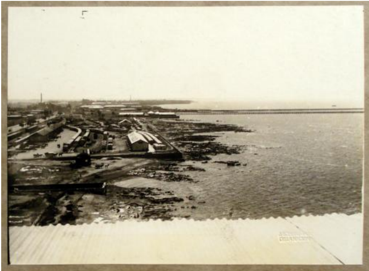
PLAYA DE DESCARGA DE LA ESTACIÓN CENTRAL
