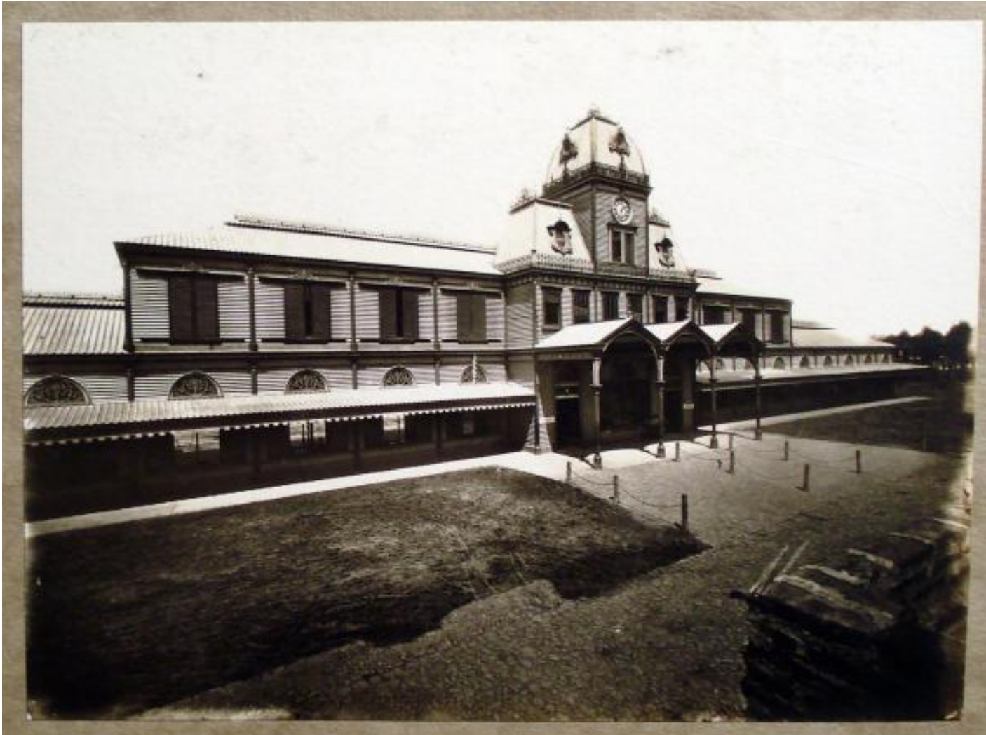
ESTACIÓN CENTRAL Frente
