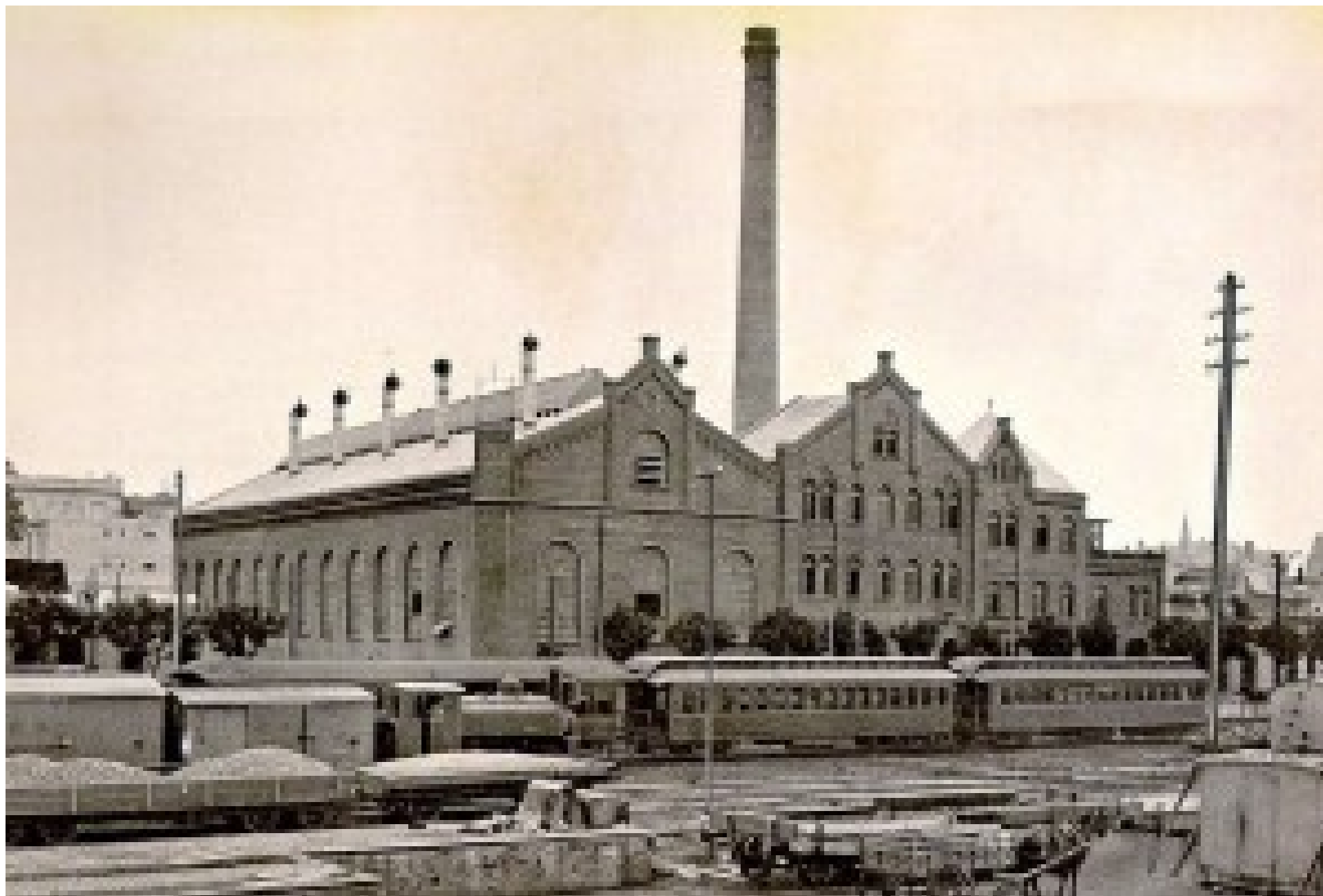
USINA DE LA COMPAÑÍA ALEMANA TRANSATLÁNTICA DE ELECTRICIDAD (CATE) Paseo de Julio y calle Montevideo 1910
