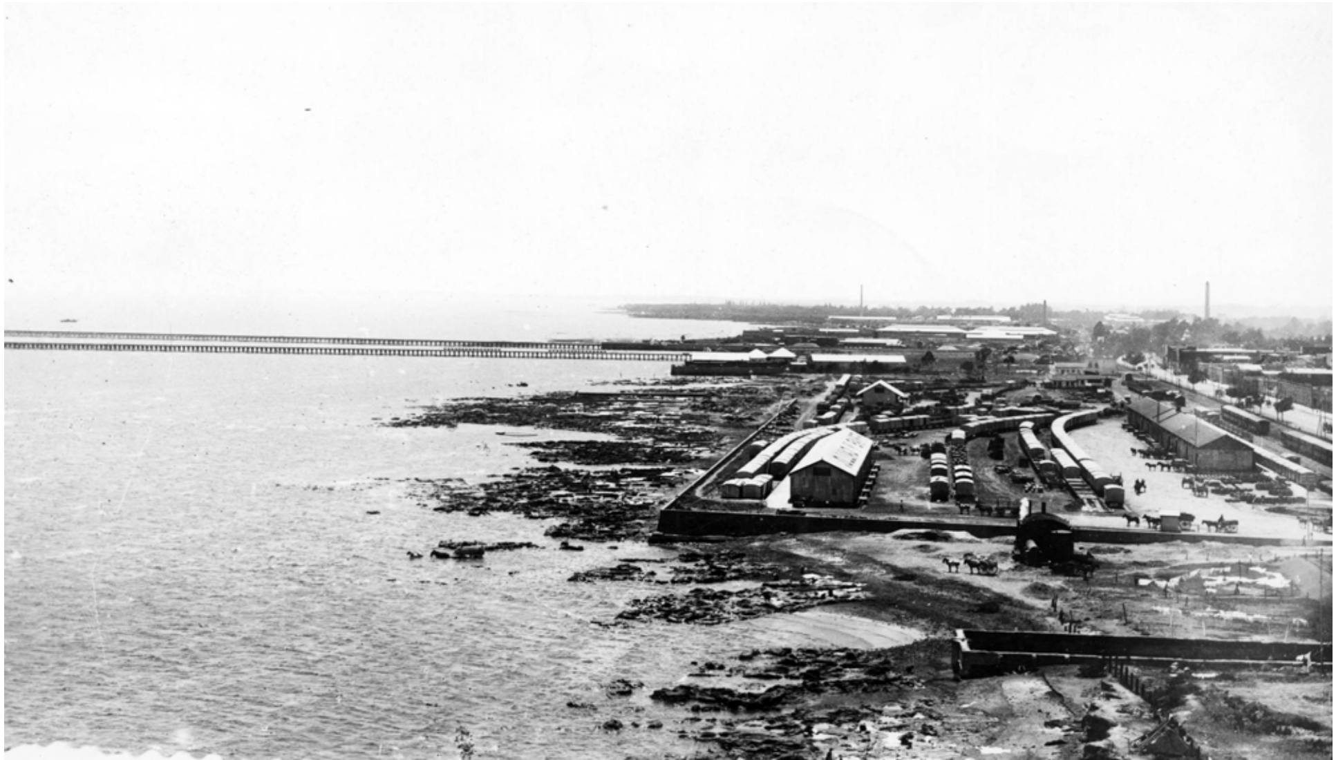
VISTA DE LA RIBERA DEL RÍO DE LA PLATA EN LAS CERCANÍAS DE LA CASA DE GOBIERNO
