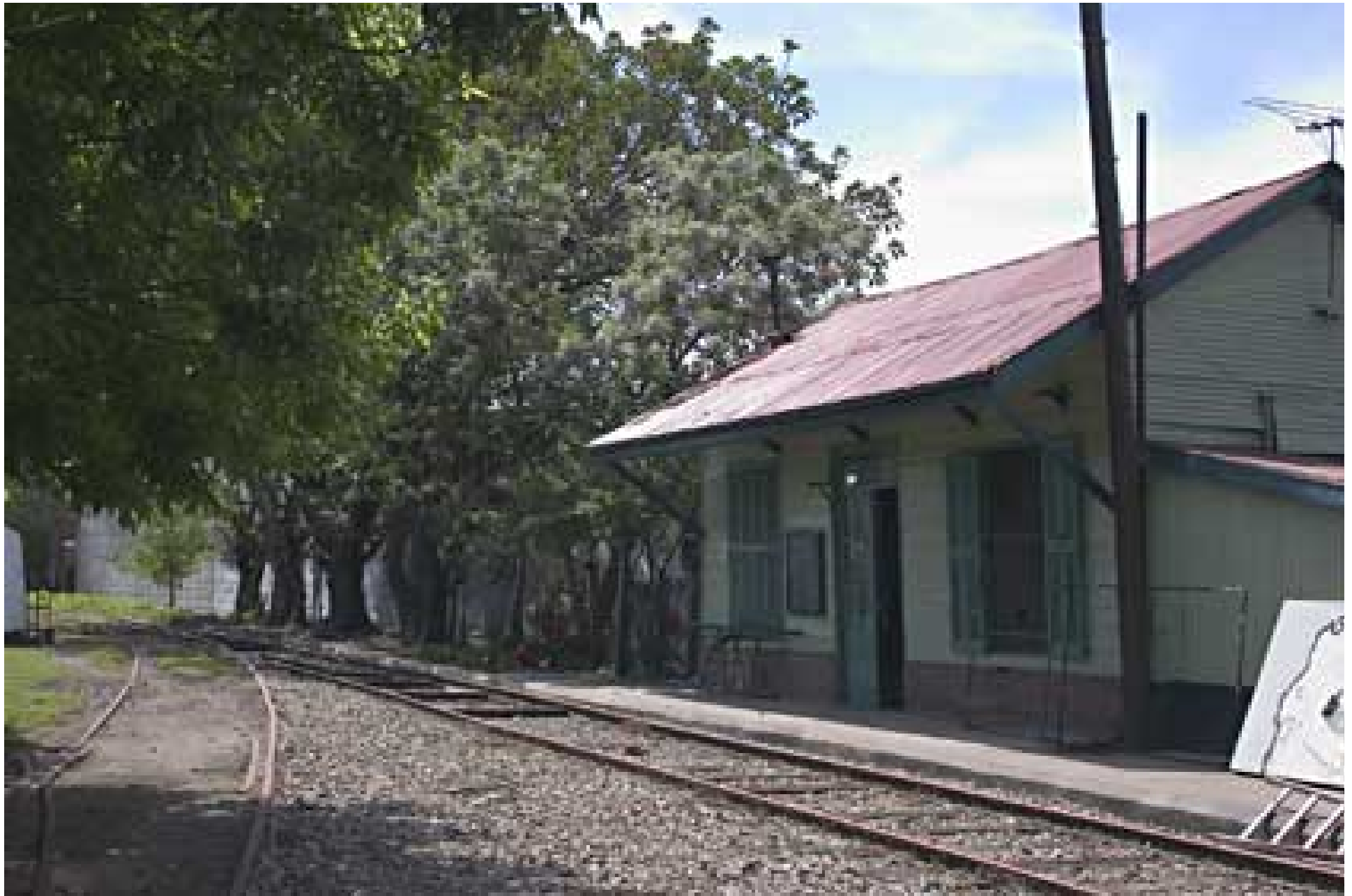
ESTACIÓN FERRO PORTUARIA BARRACA PEÑA La Boca
