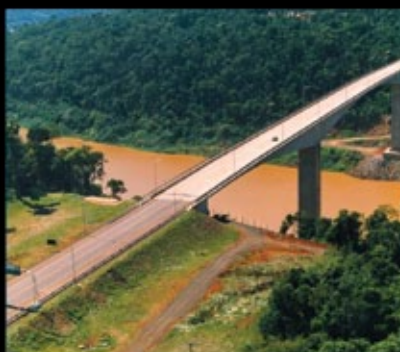
PUENTE INTERNACIONAL TANCREDO NEVES
