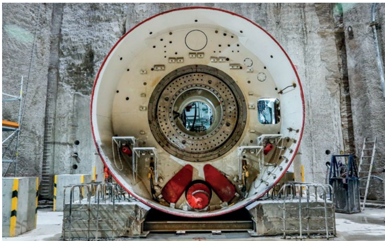
-ALEMANA. La tunelera con la que se hará el emisario fue diseñada y construida en gran medida por la firma Herrenknecht.
