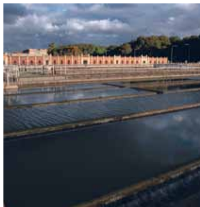
– DECANTACIÓN. El agua avanza por piletones y se limpia con la ayuda de la gravedad.
