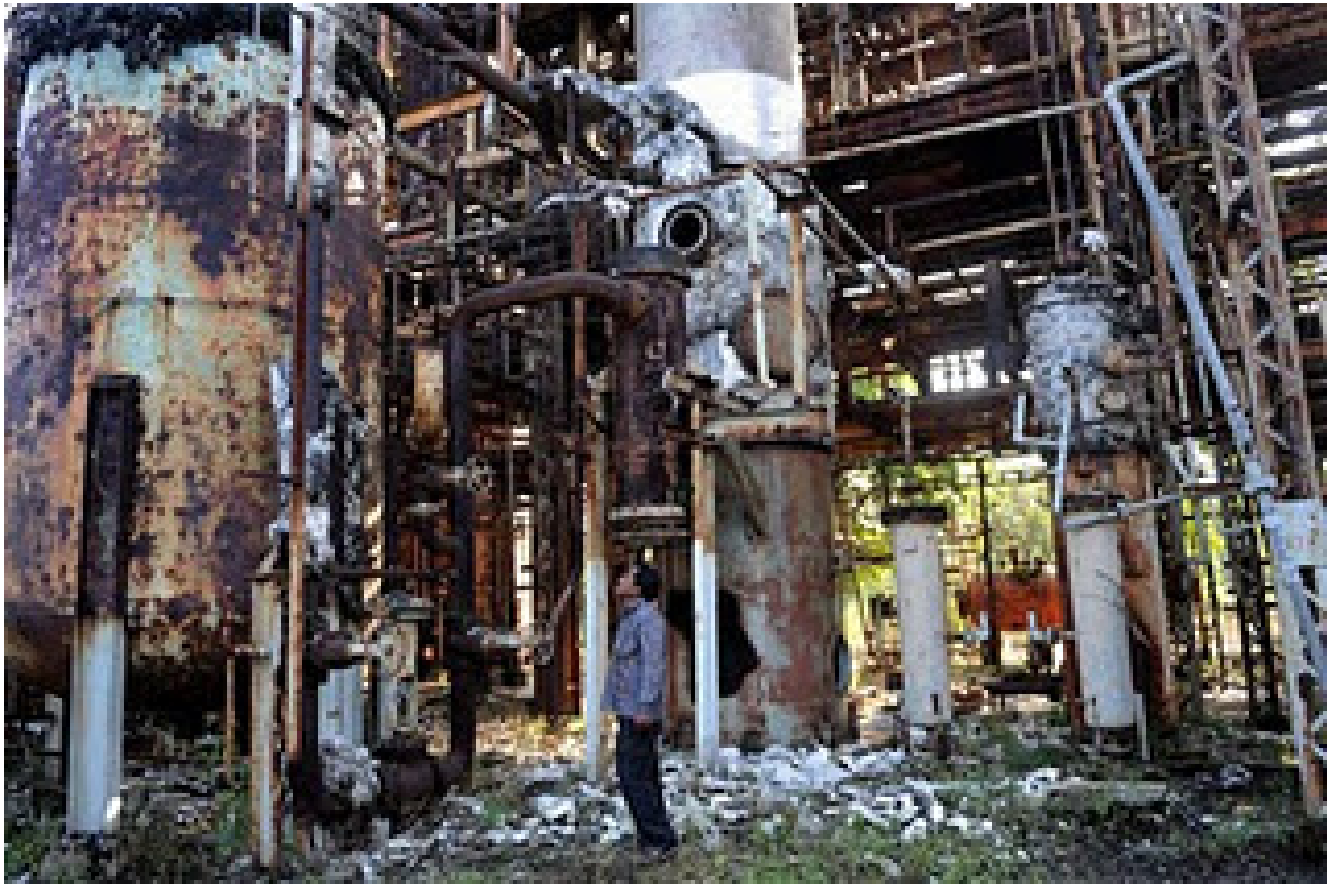
VISTA DEL INTERIOR DE LA PLANTA DESPUÉS DEL ACCIDENTE
