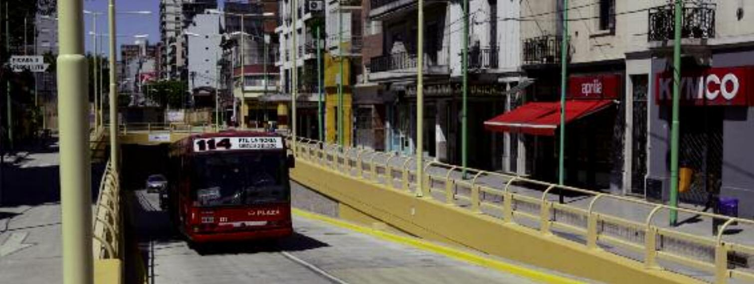
Las tareas consisten en construir un paso bajo nivel vehicular con una altura libre de paso de 3,60 metros y tres carriles con un único sentido de circulación hacia el Noreste (hacia Av. Del Libertador).
